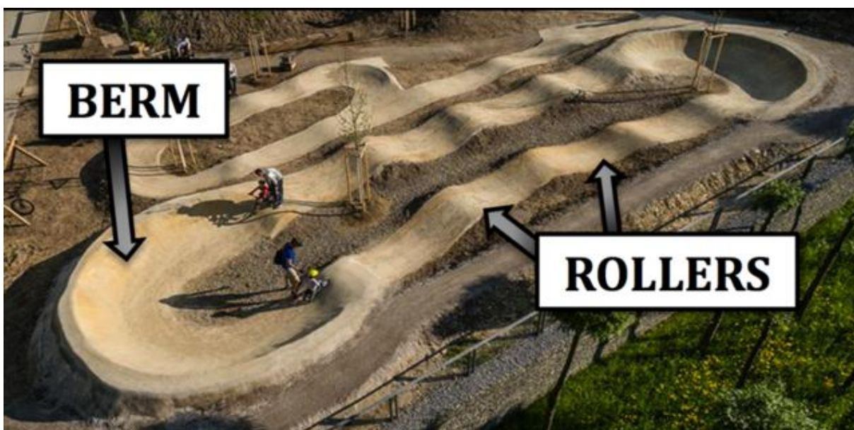
Bilde 23. Eksempel på enkel pump track.
